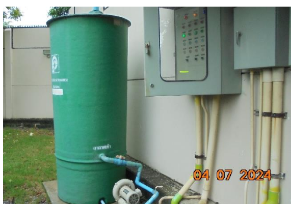
รูปที่ ก-13 ถังดักตะกอนฝอย
